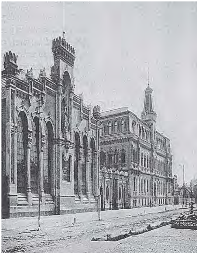
FIGUR 1. Rigas industrialisering under senare hälften av 1800-talet och under 1900-talet var expansiv och dramatisk. Den har också satt sina spår i stadens centrala delar och än finns många fabriksbyggnader kvar från denna storhetsperiod i stadens historia. En av dessa anläggningar är VEF.
