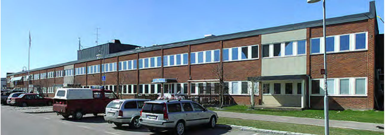
Kontoret från nordost. De tre ursprungliga entréerna framhävs i dag av partier med skivbeklädnad. Den långa fasaden delas upp av de regelbundet placerade lisenerna.
