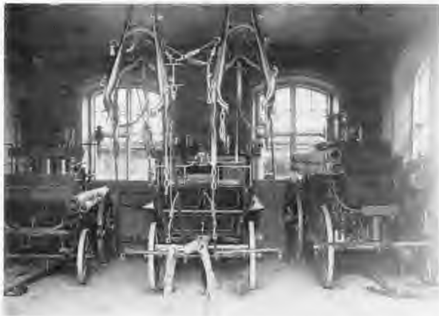
Interiör av utryckningshallen.
