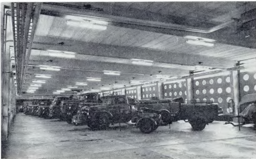
Utryckningshallen för brandbilarna.
