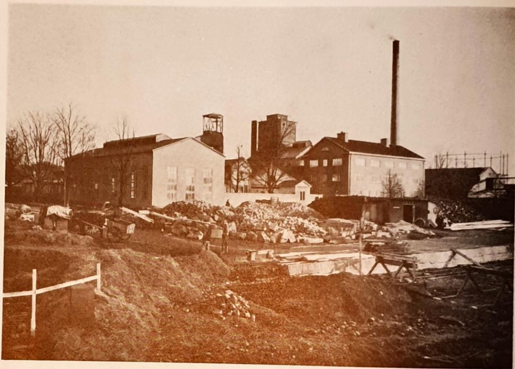
Gasverket sett från hamnplan.
